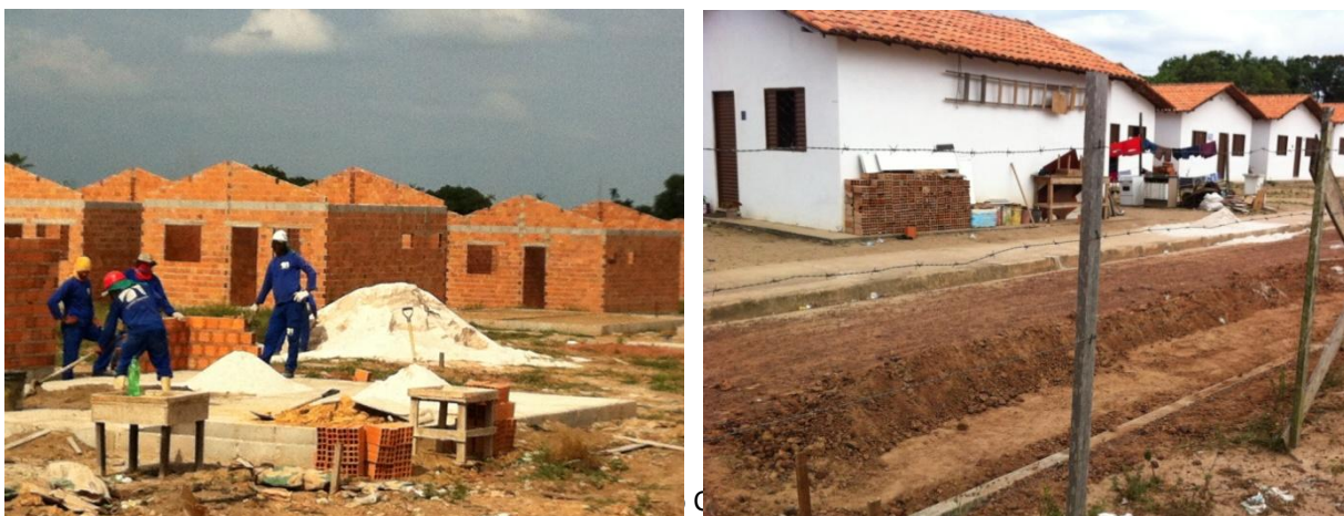
Figuras 2 e 3: Construção de Unidades Habitacionais no Empreendimento Comunidade Providentinos.
