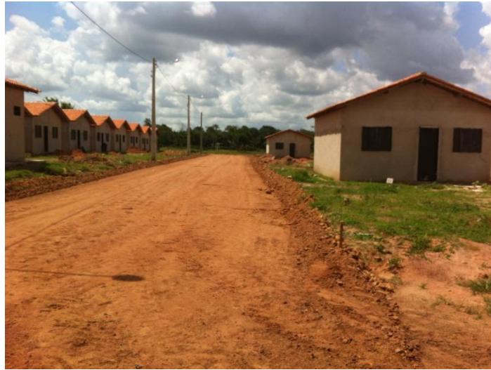
Figura 3: Obras do Sistema Viário no Residencial Comunidade Providentinos.
