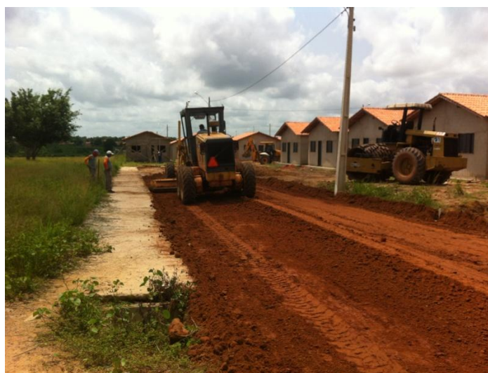
Figura 2: Obras do Sistema Viário no Residencial Comunidade Providentinos.
