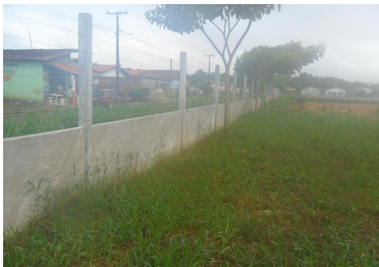
Figuras 6 – Construção de fundação e muro da escola no Residencial Jardim das Garças I
