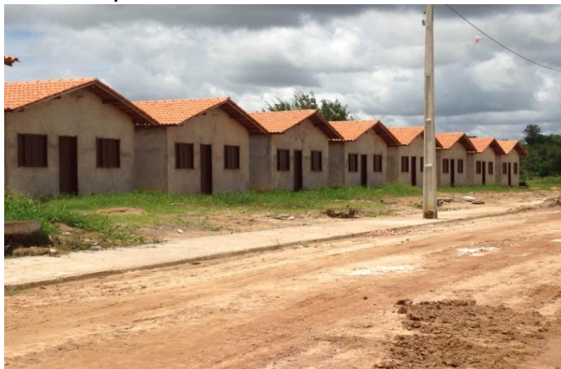
Figura 2: Unidade Habitacionais em fase de conclusão do Empreendimento Comunidade Providentinos.
