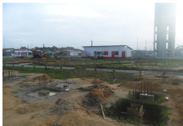
Figuras 4 e 5 – Construção de fundação e muro da escola no Residencial Jardim das Garças I
