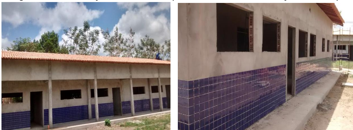
Figuras 1 e 2: Construção da escola no Empreendimento Jardim das Garças 1ª e 2ª Etapas.
