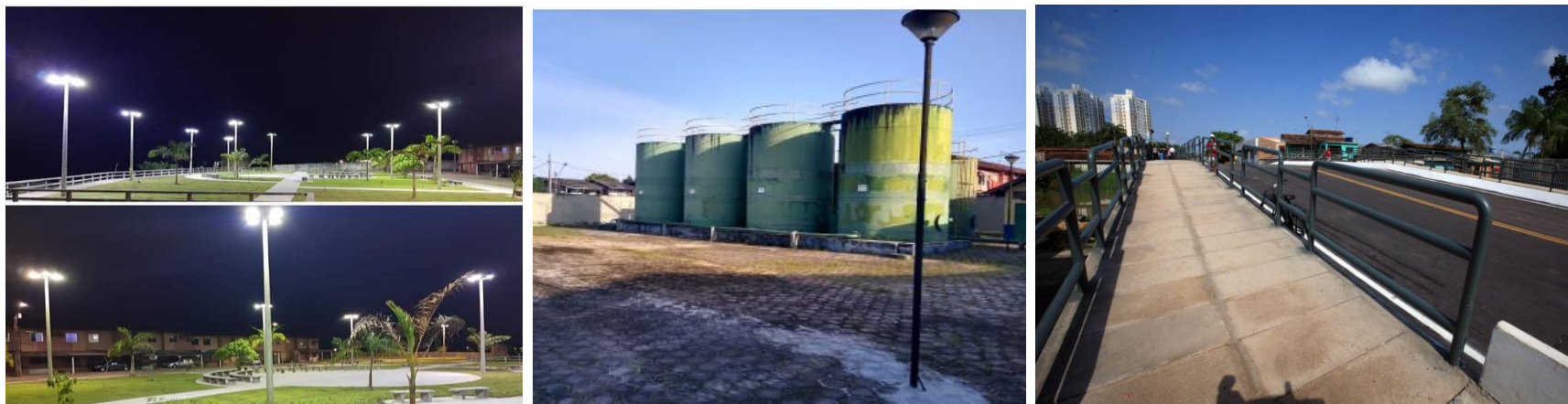
Figuras 11 a 13: Execução de infraestrutura e equipamentos comunitários em assentamentos precários, Belém.
