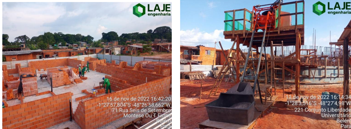
Figura 25 e 26 – Obras em execução, Residenciais Liberdade, Belém.
